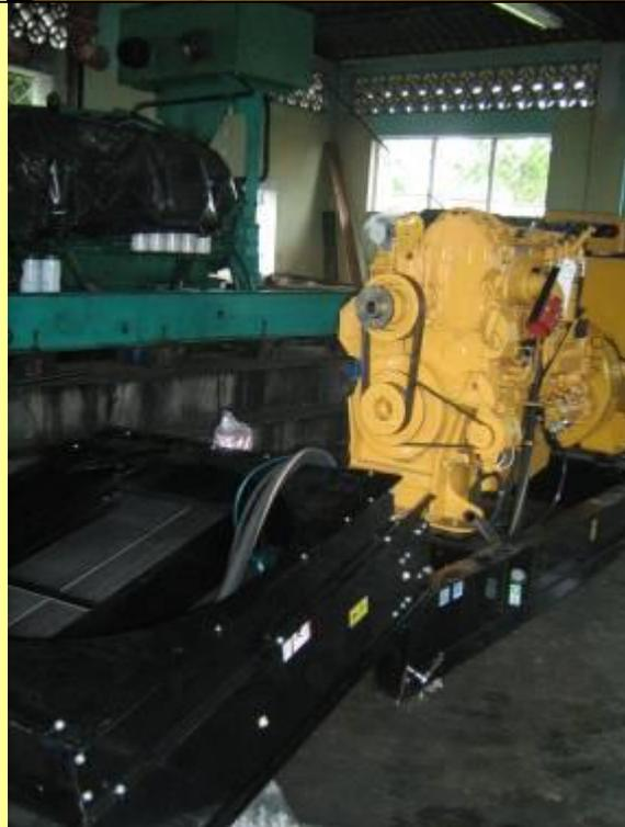
**Acople de radiador del grupo electrógeno.**
