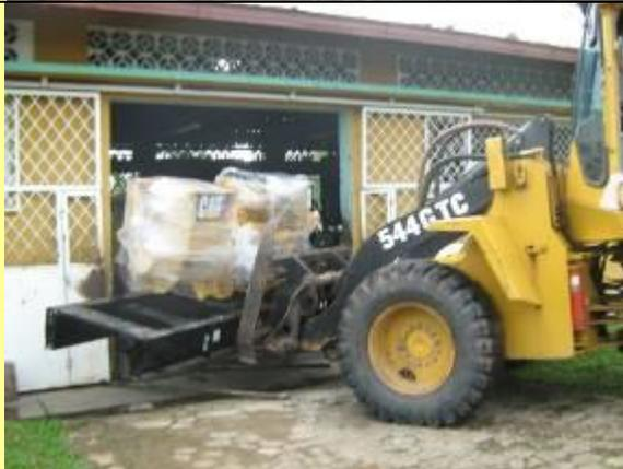
Ubicación de grupo electrógeno en sitio, cargador utilizado para maniobra de traslado y ubicación del equipo.
