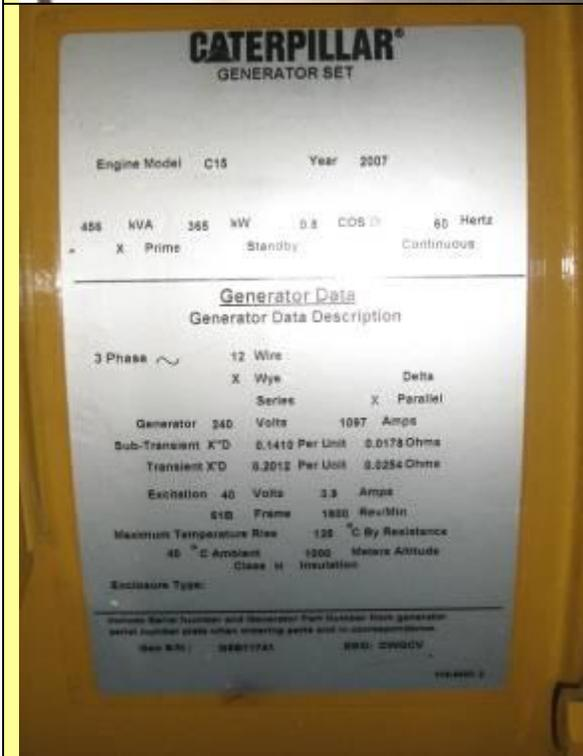
Placa de datos de grupo electrógeno debe ser reemplazada, ya que las conexiones fueron modificadas en la sede del distribuidor (R462) y por disposiciones de control y normatividad es imperante que el grupo electrógeno describa por medio de la señalética las tensiones y valores de las variables físicas para las cuales está configurado el grupo electrógeno
