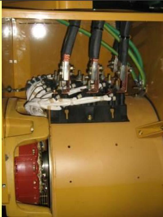
**Inspección de líneas de fuerza en el alternador del grupo electrógeno.**
