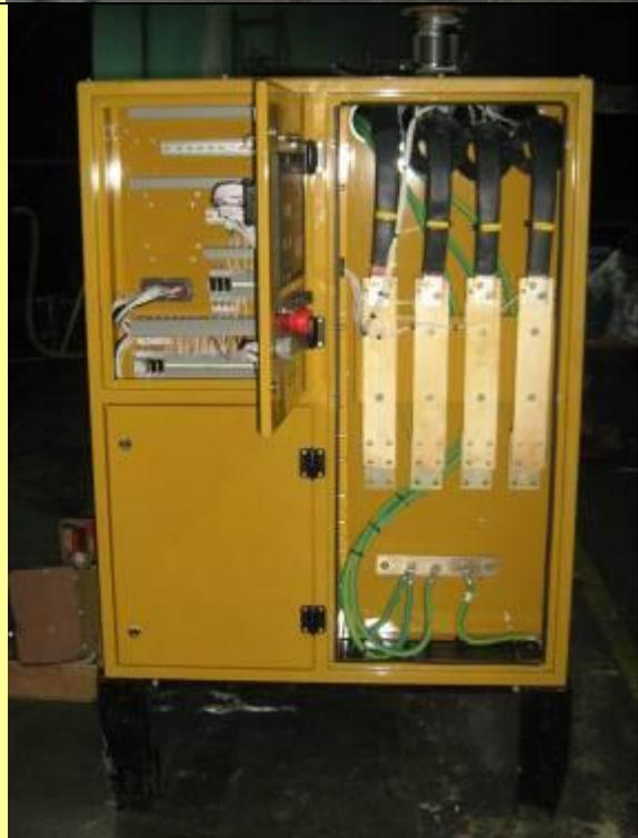
Gabinete de líneas de fuerza en el grupo electrógeno a disposición de interconexión de las conexiones de fuerza.
